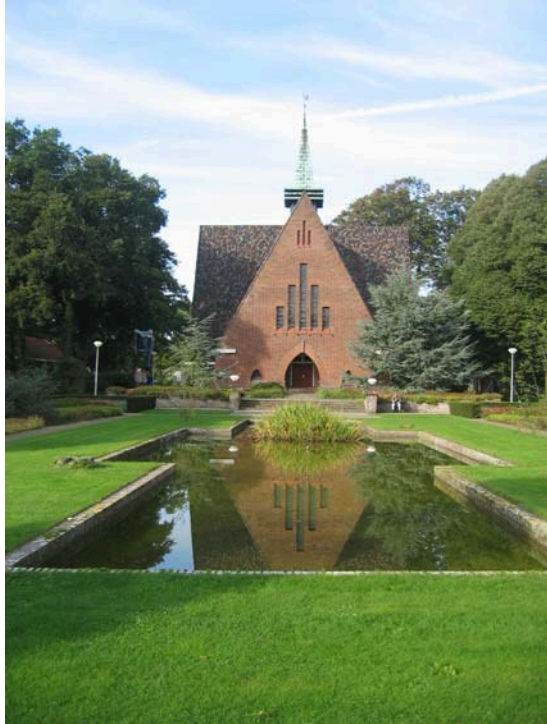
Zicht op de zuidgevel vanuit het 'paviljoensplein'
